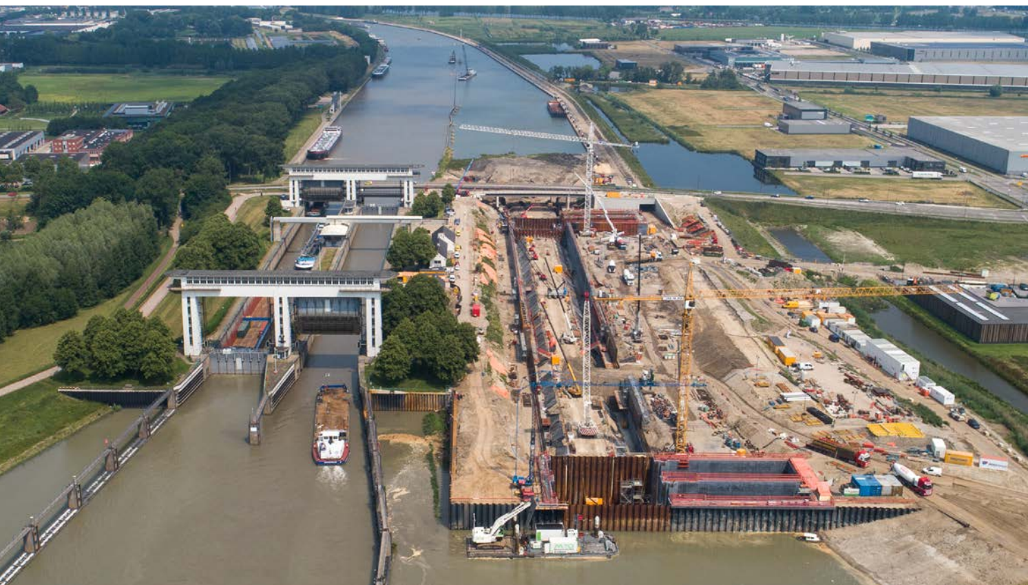
Derde kolk in aanbouw. (Foto: Rindert van den Toren)
